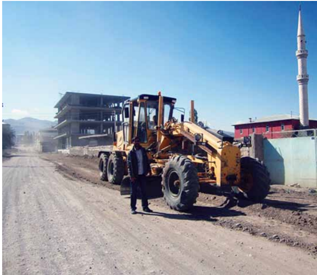
Yeni Mahallede yapılan imalatlar
