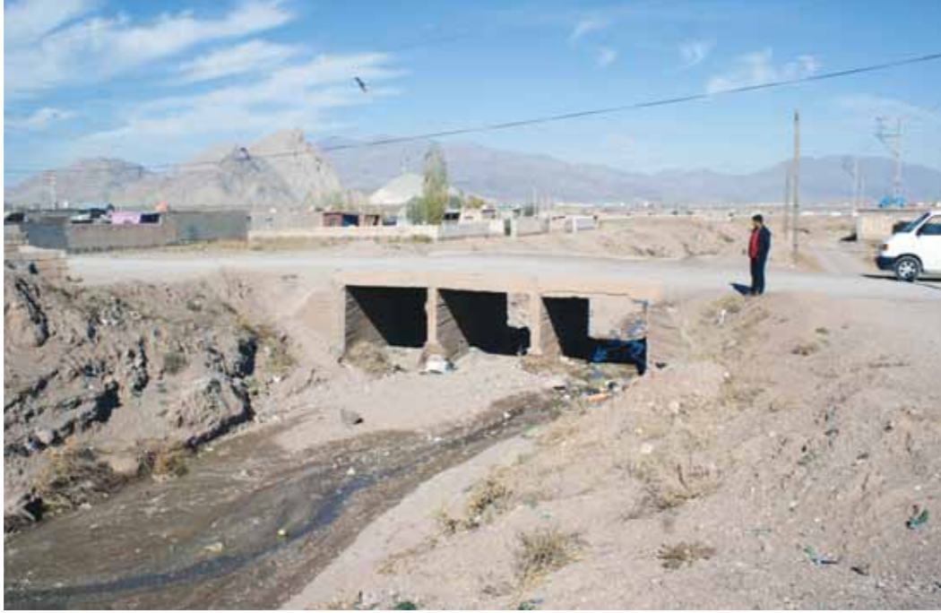
Büyük Ağrı mahallesinde Ağır Kaya Petrol Karşında 4 adet menfez köprü yapımı imalatı yapılmıştır.
