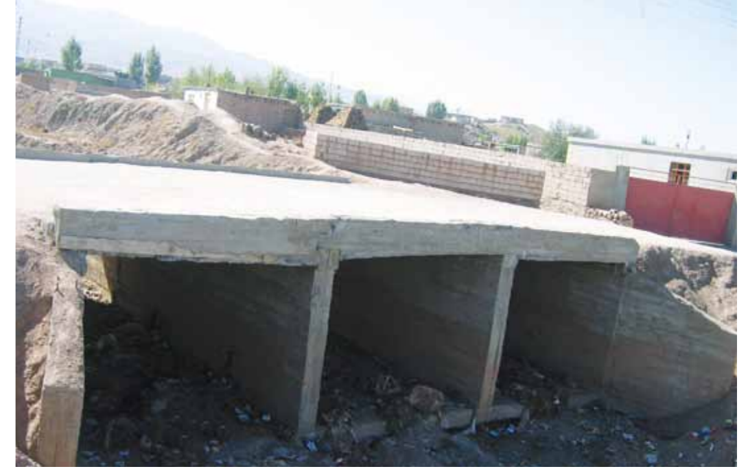
Toplamda 16 adet köprü ve menfez yapılmıştır.
