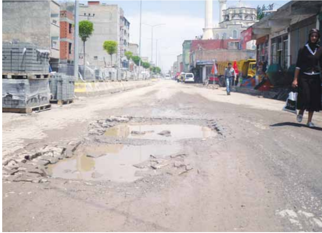
Bahçelievler sokakta 2.500 m 2 ve Yatılı İlköğretim Bölge yolu 62.300 m 2 parke taşı döşeme imalatı yapılmıştır.
