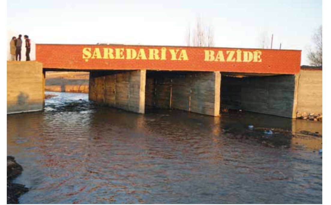
Barış Mahallesi ile Uluylol mahallesini birbirinden ayıran dere üzerinde 1 adet köprü imalatı yapılmıştır.
