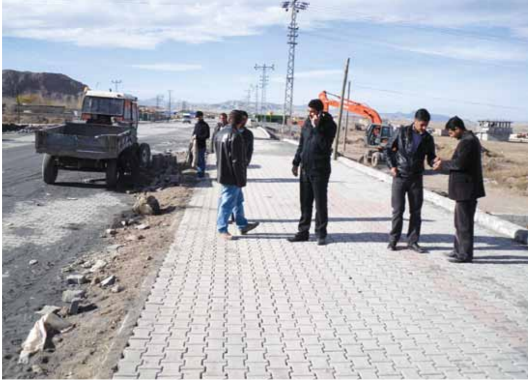
Meryem ana caddesi 13.874 m 2 parke taşı döşeme imalatı yapılmıştır.
