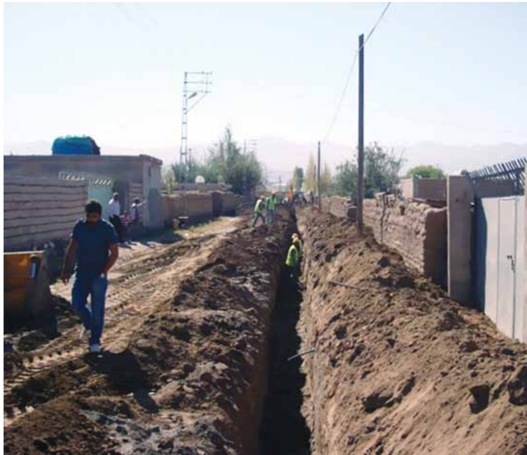
Hürriyet Mahallesinde yapılan imalatlar
