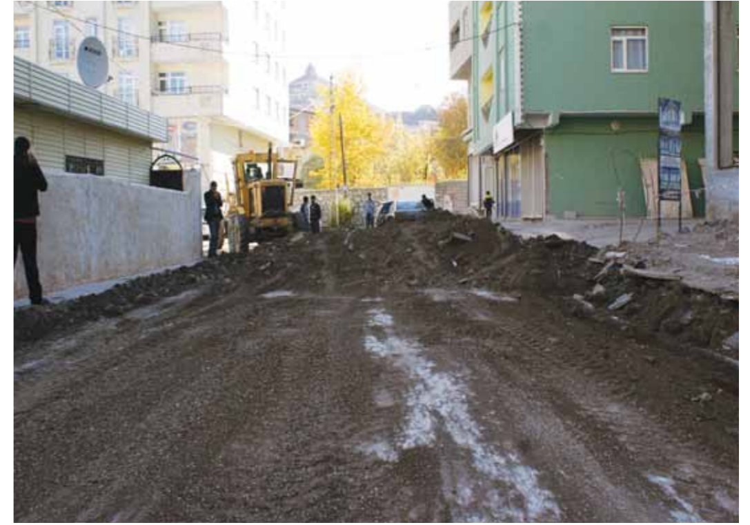
Toplamda bordür ve oluk yapımı dahil 322 bin metrekarelik yol yapımı ve 25000 metrekarelik de yama yapımı gerçekleştirilmiştir.
