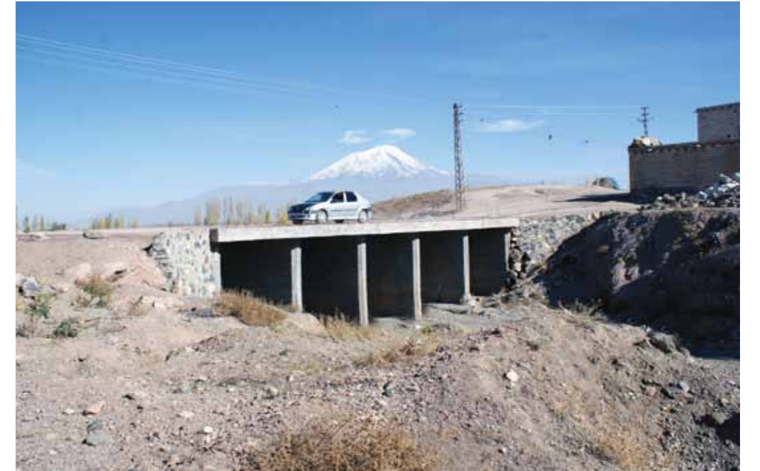
Sarı Gül mahallesinde adliye arkasında mahalleyi ikiye bölen dere üzerine 1 adet köprü imalatı yapılmıştır.
