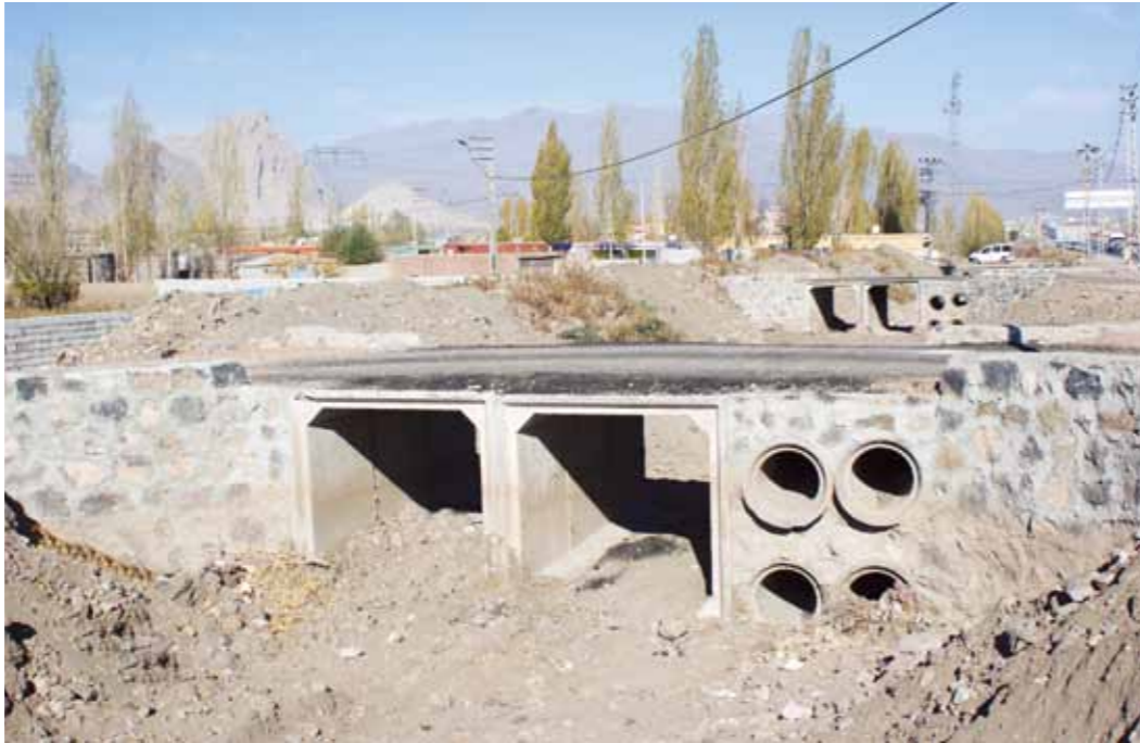
Yanoba Köyü yolu güzargahın da 1 adet menfez ve farklı yerlerde de 4 adet menfez köprü yapımı imalatı yapılmıştır.
