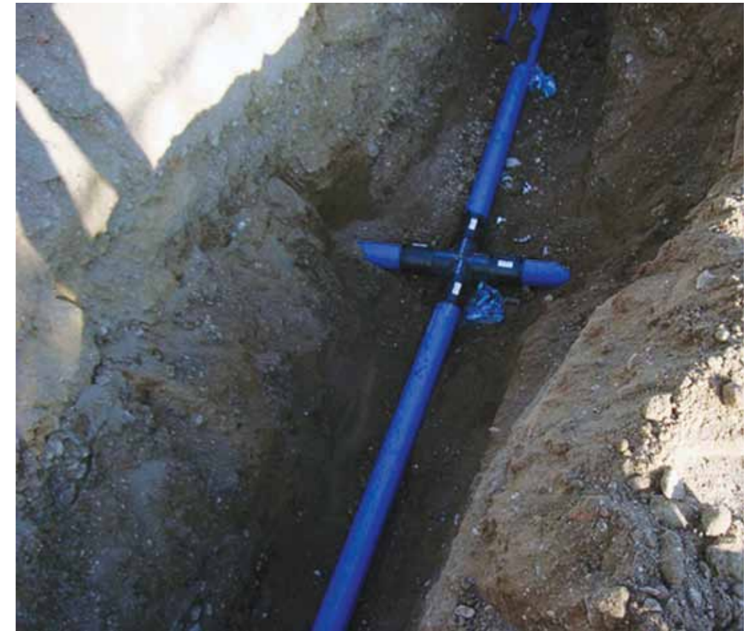
Vatan Mahallesiinde yapılan çalışmalar
