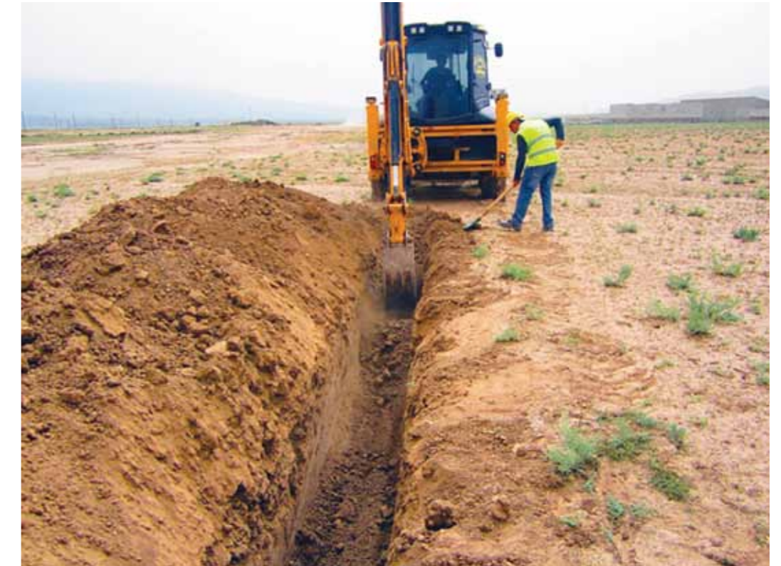
Hürriyet Mahallesinde yapılan imalatlar
