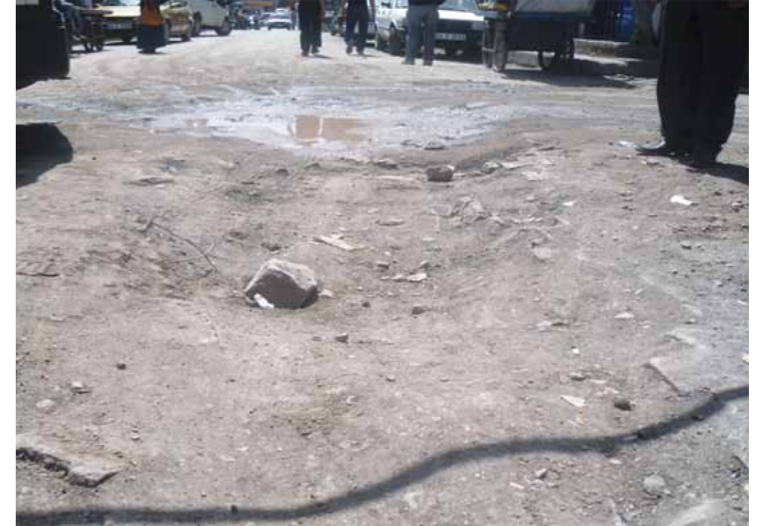
Tuhafiyeciler Caddesi 11000 m 2 parke taşı döşeme imalatı yapılmıştır.
