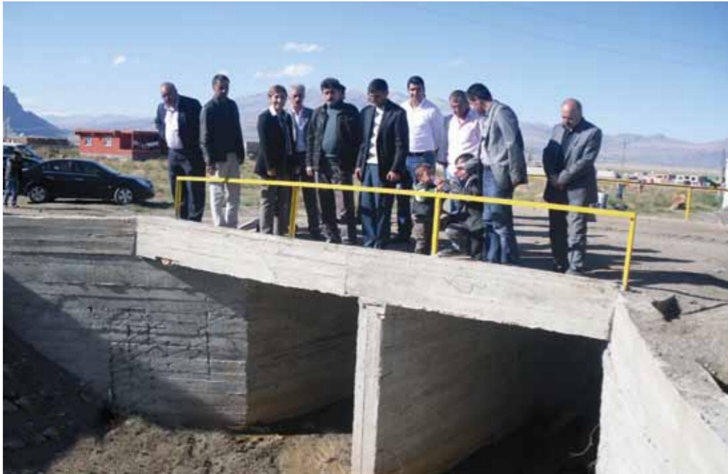
Hürriyet mah Mal meydanında bulunan dere üzerinde 1 adet köprü imalatı yapılmıştır.
