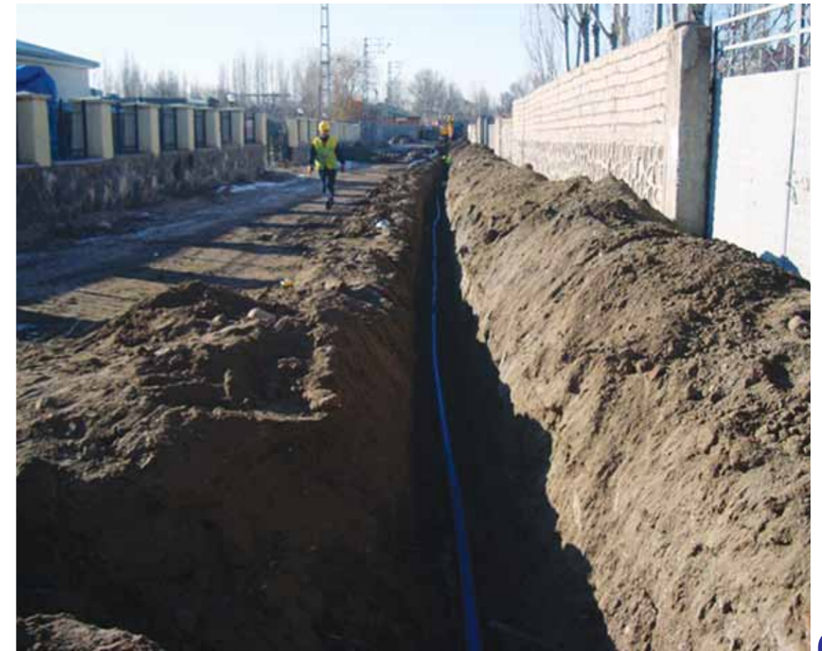
Büyük Ađrı Mahallesi'nde yapılan çalışmalar
