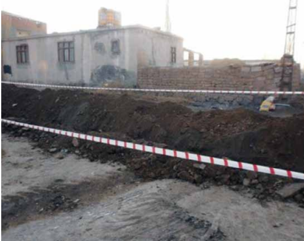
Yeni Mahallede yapılan imalatlar
