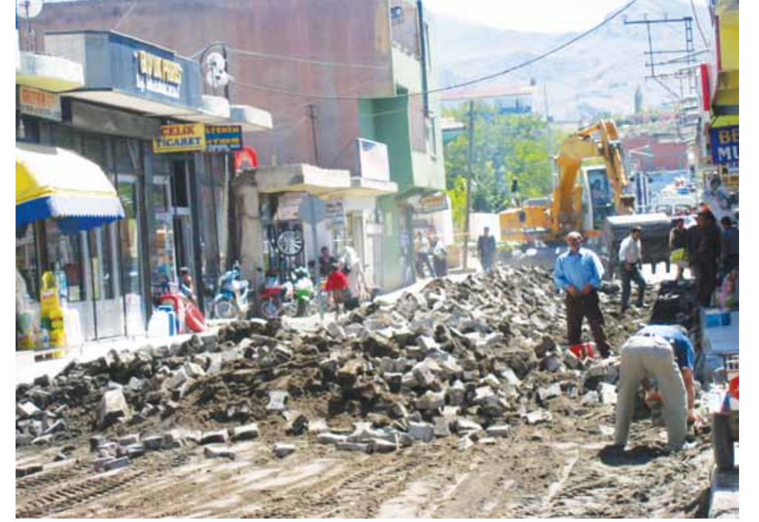
Güven Caddesi 12322 m 2 parke taşı döşeme imalatı yapılmıştır. (yapılmadan önceki hal)
