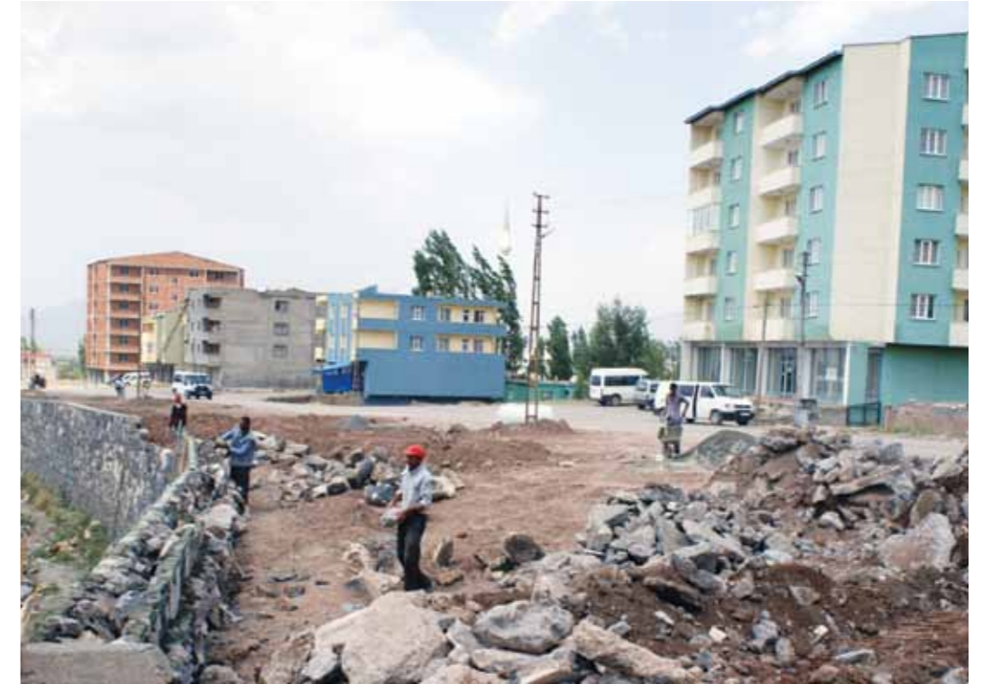
Yönetime geldiğimizde ilk işi olarak kötü olan merkez yollarımızı kilitli parke taşı ile yeniledik.. Ehmedê Xanî Mahallesi Stadyum Yolu işi kapsamında 46.200 m 2 parke taşı döşeme ve kaldırım düzenleme işi gerçekleştirildi.
