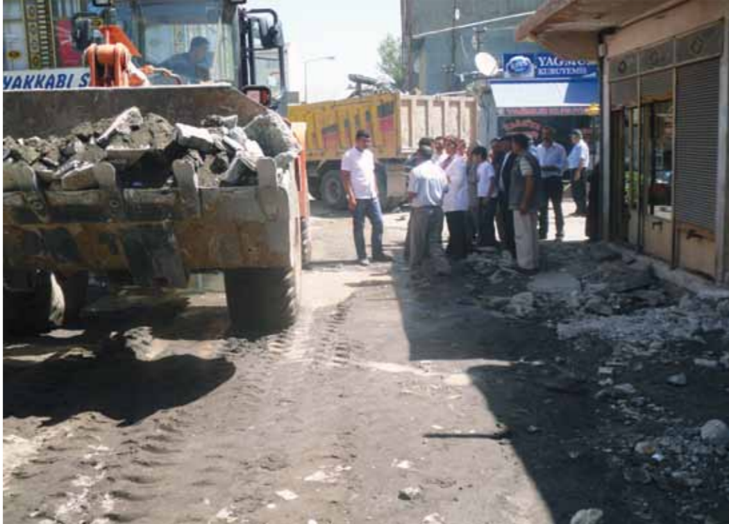
Ağrı Caddesi 42.136 m 2 parke taşı döşeme imalatı yapılmıştır.
