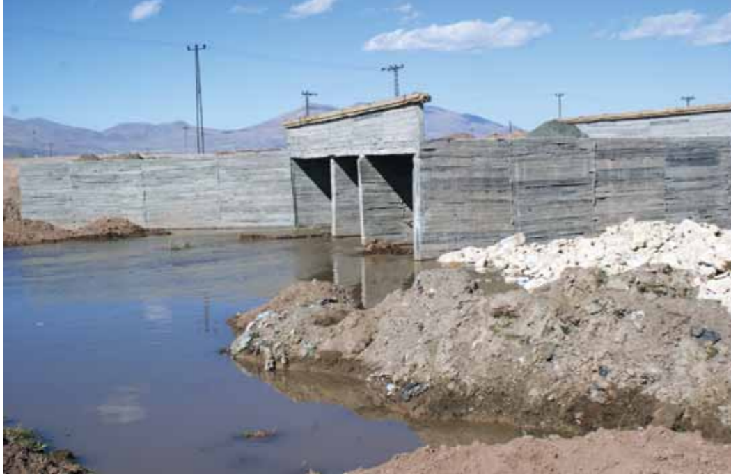
Hasankeyf mahallesinden geçen dere üzerine 1 adet köprü imalatı yapılmıştır.
