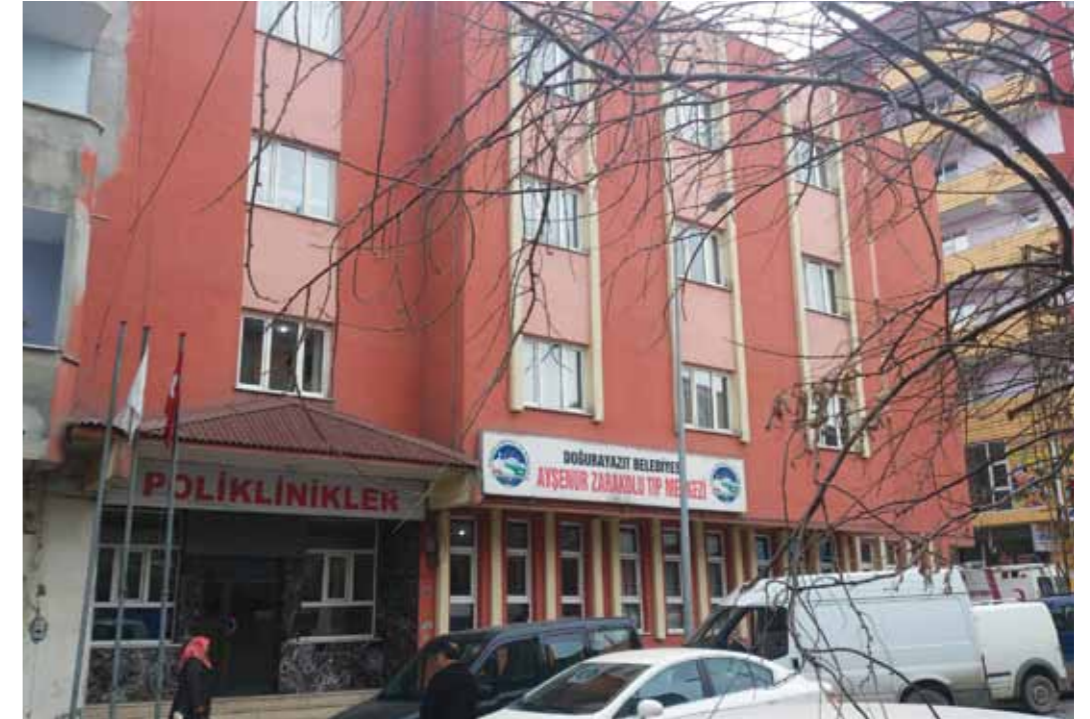
Tıp Merkezimiz belediyemize ait beş katlı bir binanın üç katında faaliyet vermektedir.
