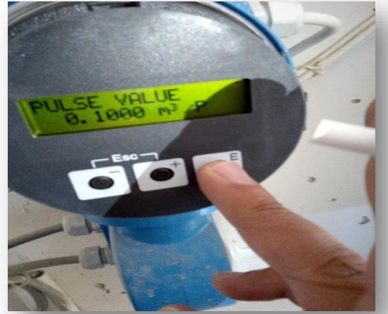
ŞEKİL 14 SCADA BAKIM ONARIM ÇALIŞMALARI
