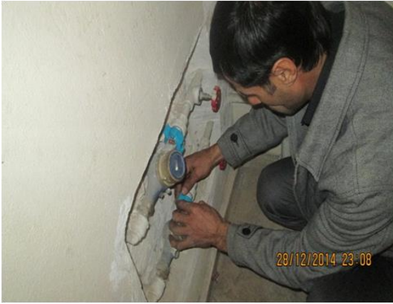
Çiftepınar Mah.de sayaçın mühürlenmesi ve kaçak bağlantının kesilmesi
