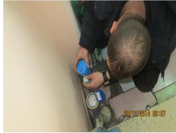
Çiftepınar Mah.de sayaçın mühürlenmesi ve kaçak bağlantının kesilmesi
