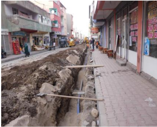
Çarşı merkezi su şebekesi döşemesi
