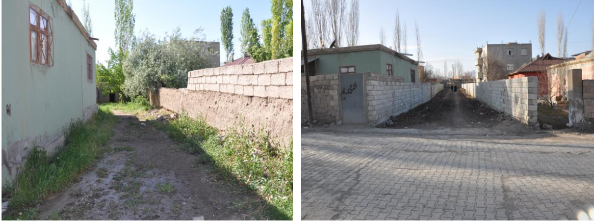
Koçkiran mahallesi yol açma çalışmaları
